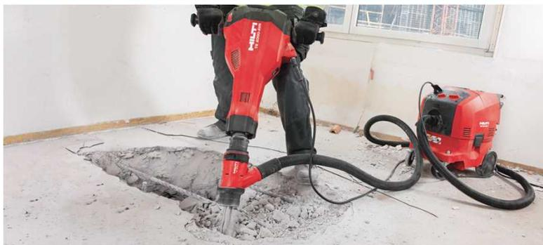
コンクリートおよび解体作業に適した、パワフルかつ超軽量の TE-S コネクションエンド解体ハンマー
