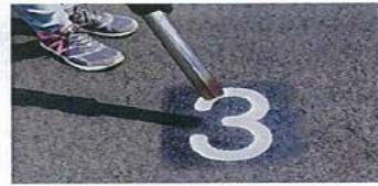
④バーナーで加熱し、溶着する。
