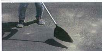
①シート設置面の清掃
